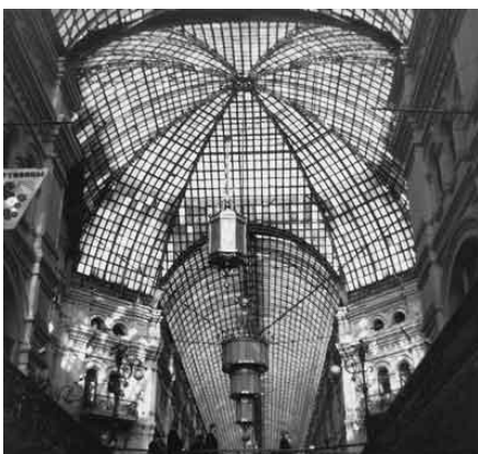
Металлостеклянные своды и купол перекрытия Верхних торговых рядов на Красной площади в Москве. Фото С.В. Шухова 1960-х годов
